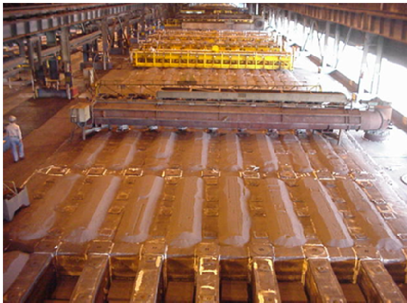
Figura 7 Forno de cozimento de anodos.
