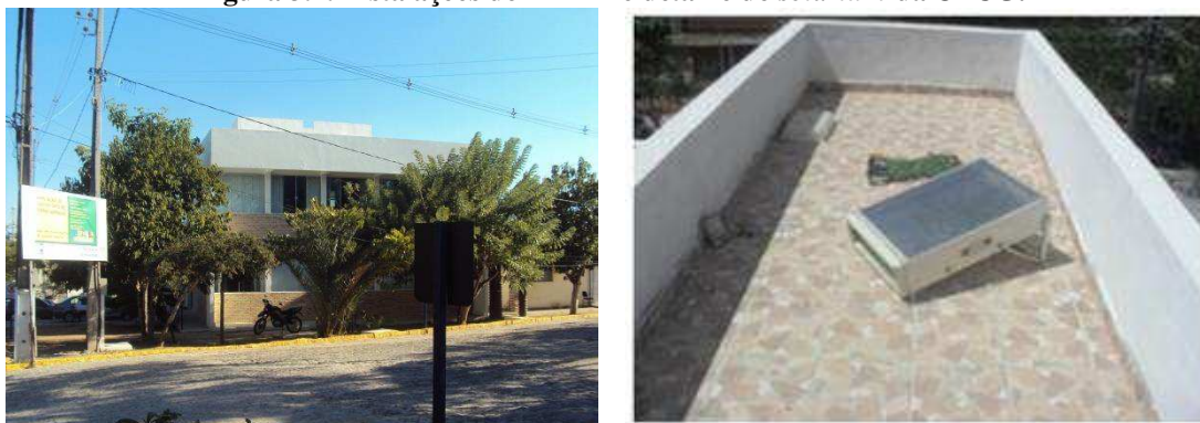
Figura 3.1. Instalações do LEMT e detalhe do solarium da UFCG.
