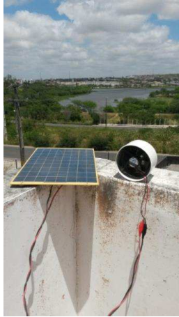
Figura 3.12. Cooler e o mini painel fotovoltaico.
