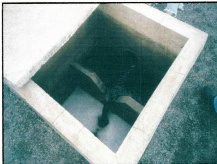
**Foto 4.21 – Caixa de passagem de percolados utilizada também com caixa de vazão**
