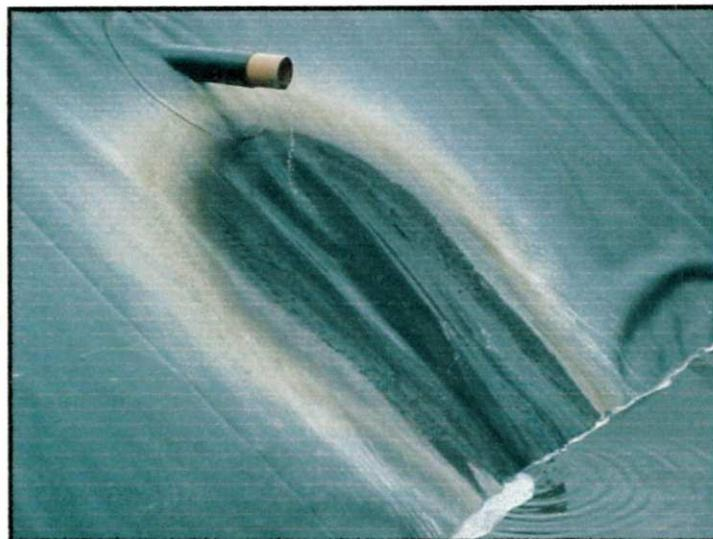
**Foto 4.19 – detalhe do dreno e da manta utilizada para impermeabilização**
