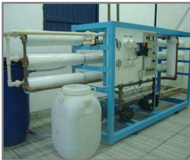
Figura 18 - Vista do dessalinizador instalado na Comunidade de Uruçu
