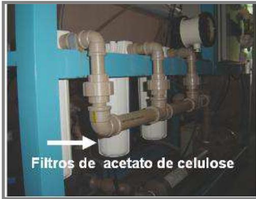
Figura 12 - Módulo dos cartuchos de acetato de celulose de 5 $\mu$ m (filtros multimeios)
