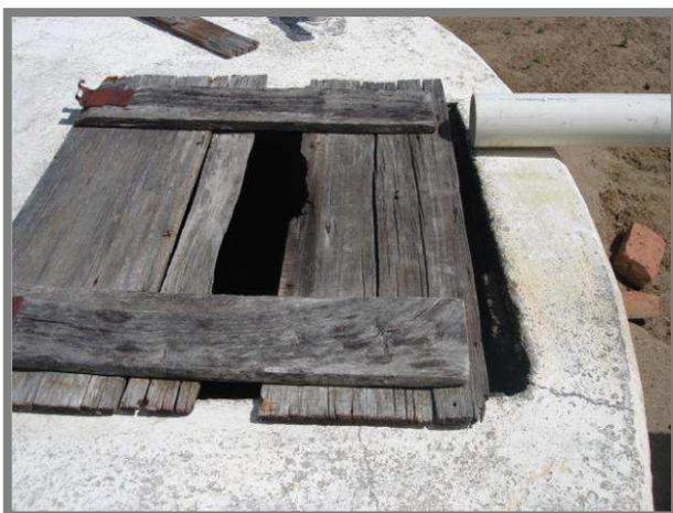
Figura 32 - Cisterna com tampa que favorece a entrada de impurezas
