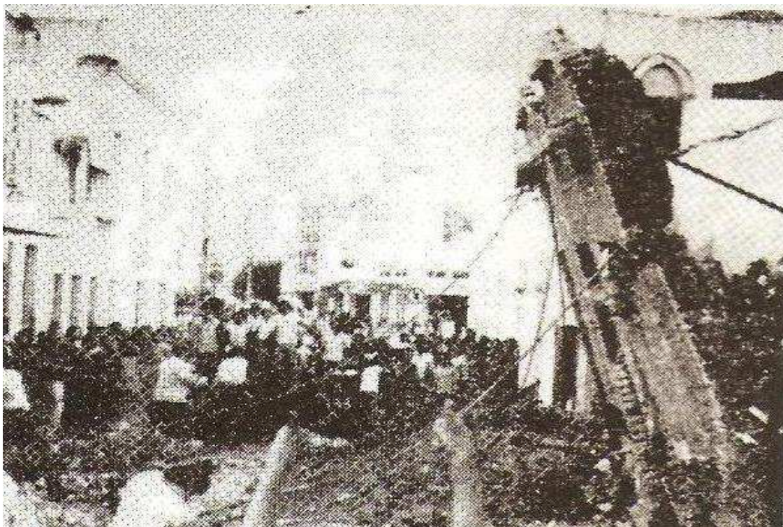
Imagem 1 – momento da derrubada da fachada de um dos casarões da Rua Padre José Tomaz. Acervo: Revista Oba!
