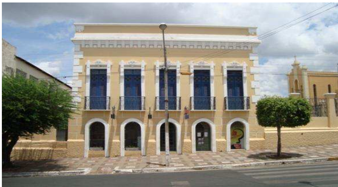
Imagem 14 – Antiga residência da família Peba, hoje transformada no Casarão Boa Vista, que abriga lojas e departamentos de serviços (10/01/2010). A estrutura de baixo, que servia como porão da casa, foi modificada para a criação de novas alas e boxes comerciais. Foto: Francisco Álisson de Oliveira.
