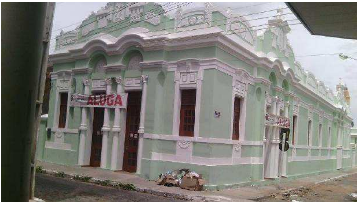
Imagem 12 – Fachada principal do Hotel Oriente, já modificada, com grandes portas em lugar dos antigos janelões.
