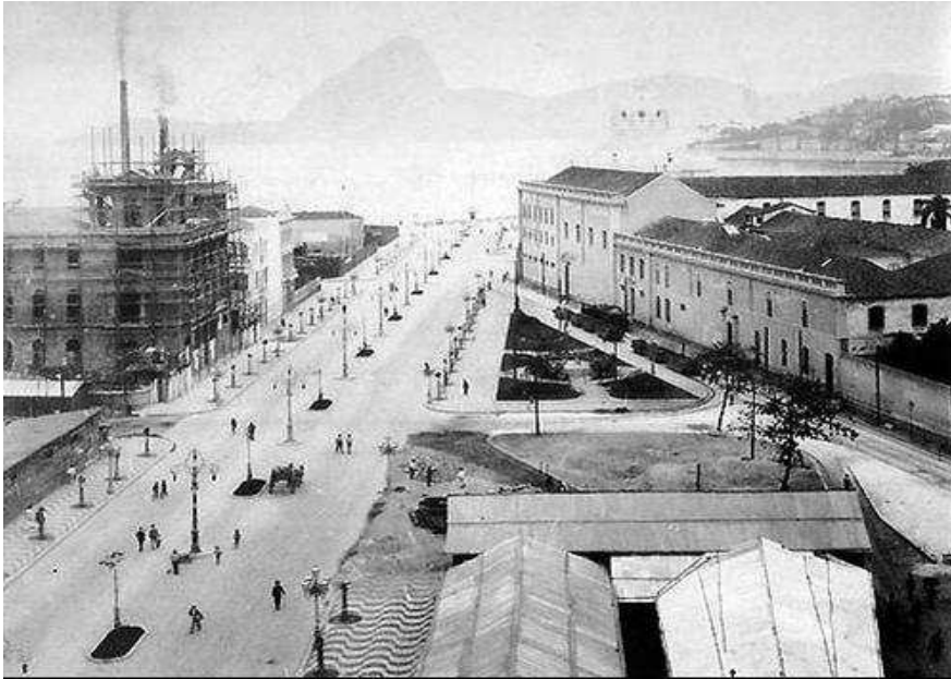
FIGURA- 03- Avenida Central do Rio de Janeiro em 1905
