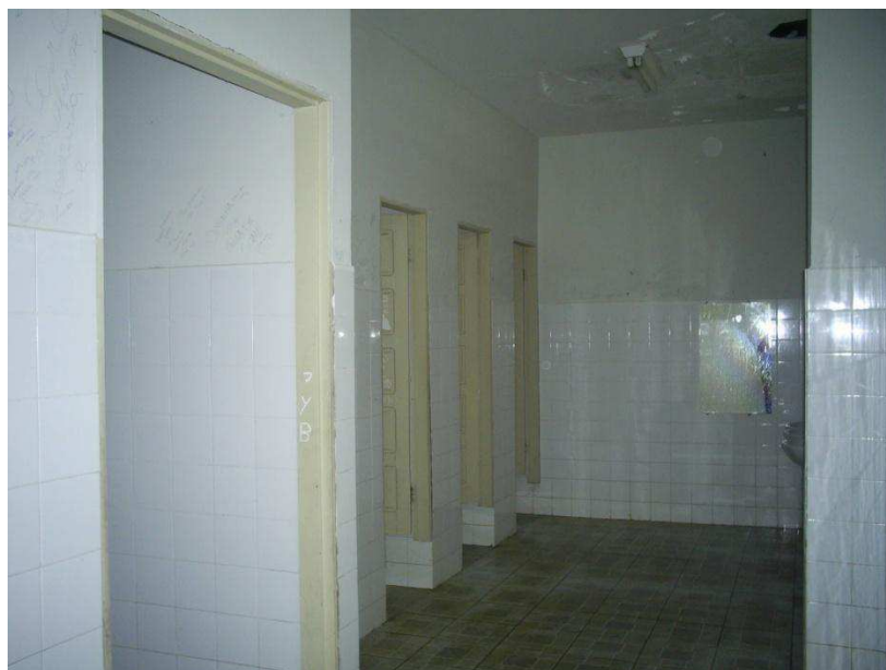
Figura 10 - BANHEIRO/ TÉRREO Fonte: autora, 2011.
