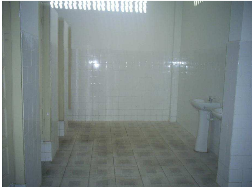
Figura 11 - BANHEIRO/ 1º ANDAR Fonte: autora, 2011.
