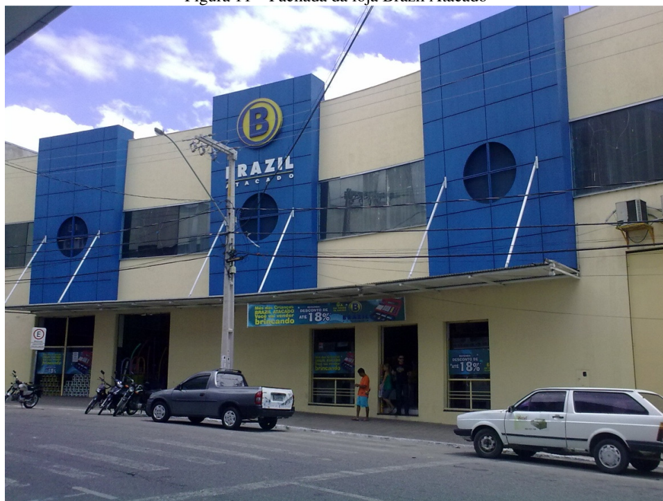
Figura 11 – Fachada da loja Brazil Atacado
