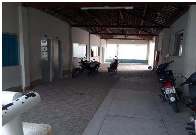
Figura 5 – Parte externa das salas de aula – Primeiro bloco
