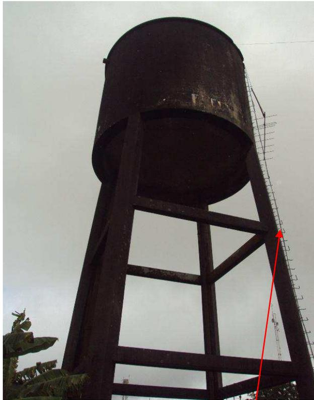
Figura 25. Imagem da caixa de distribuição de água que abastece a população de Areia, PB, construída em 1949, para abastecer aproximadamente 6 mil habitantes. Detalhes dos degraus da escada de ferro de acesso ao seu interior totalmente deteriorados.
