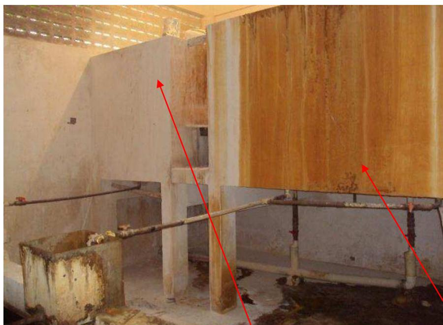
Figura 46. Imagem que mostra o tanque com solução de cal e tanque com sulfato de alumínio
