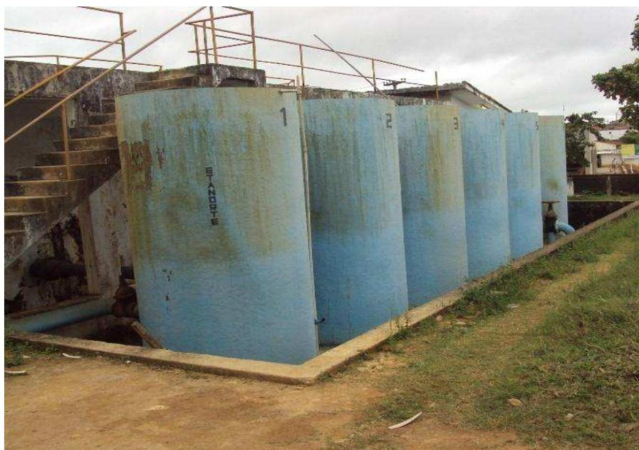
Figura 19. Filtros de água para retirar a turbidez da água.
