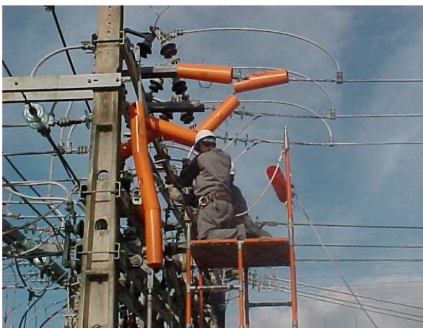
Figura 2.3: Trabalho energizado pelo método ao contato - 13,8 kV.
