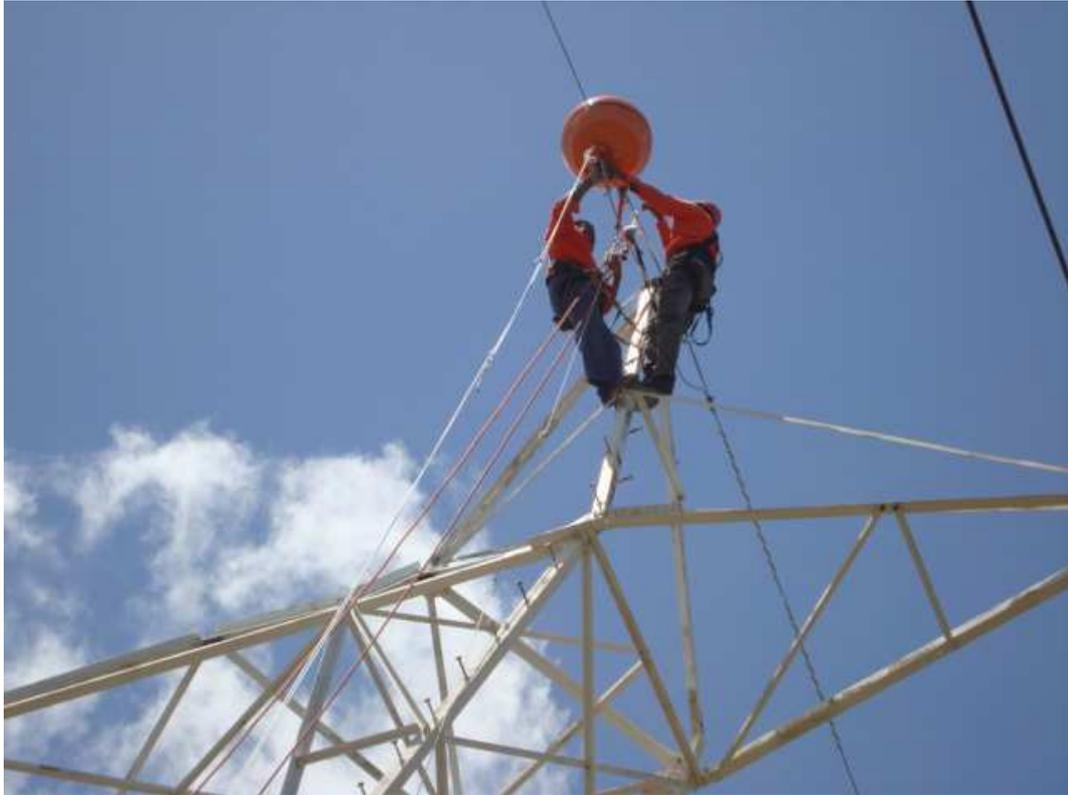
Figura 2.29: Instalação da esfera no cabo para-raios.
