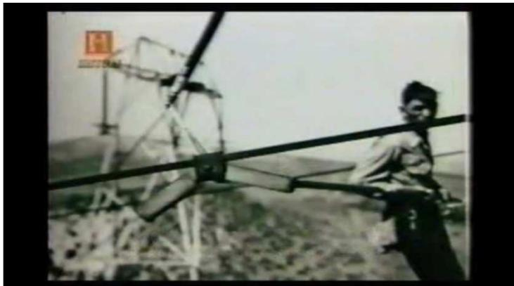
Figura 2.2: Trabalho energizado usando Hotstick.
