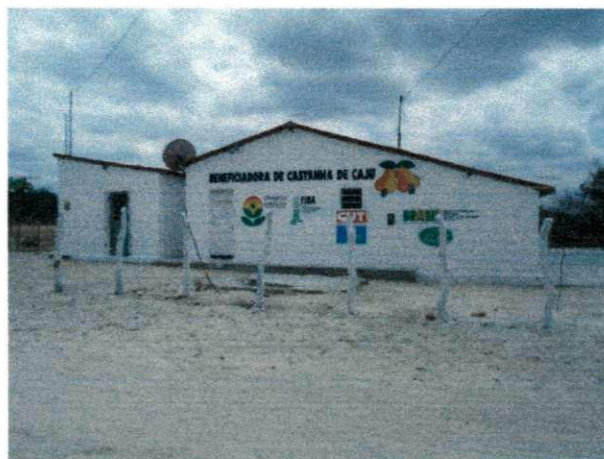
Figura 2: Unidade Beneficiadora de Castanhas de Caju Fonte: Arquivo pessoal
