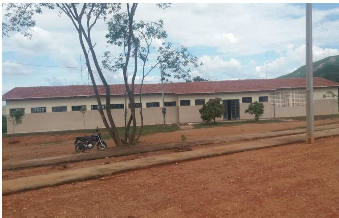
Figura 4 - Escola construída na Vila Produtiva Rural do Sítio Bartolomeu.
