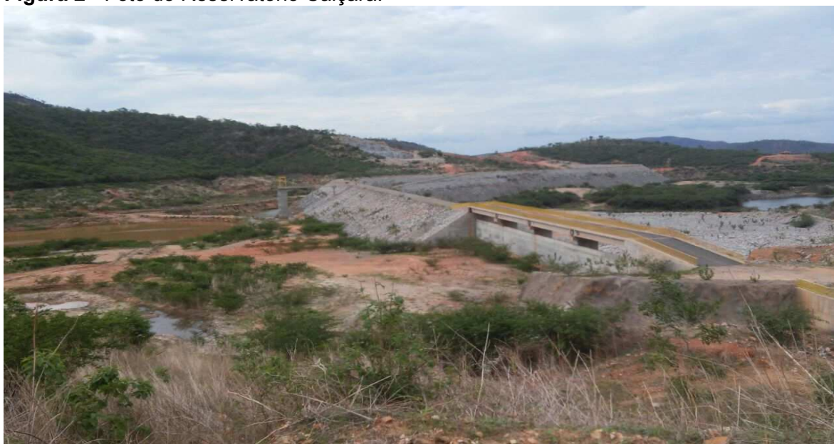
Figura 2 - Foto do Reservatório Caiçara.
