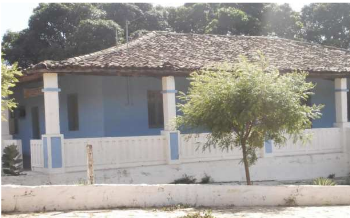
Figura 14: vista frontal do Escritório no Acampamento do DNOCS.
