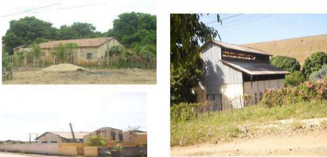
Figura 19: Antigos prédios das Oficinas mecânicas e da Casa de Força.
