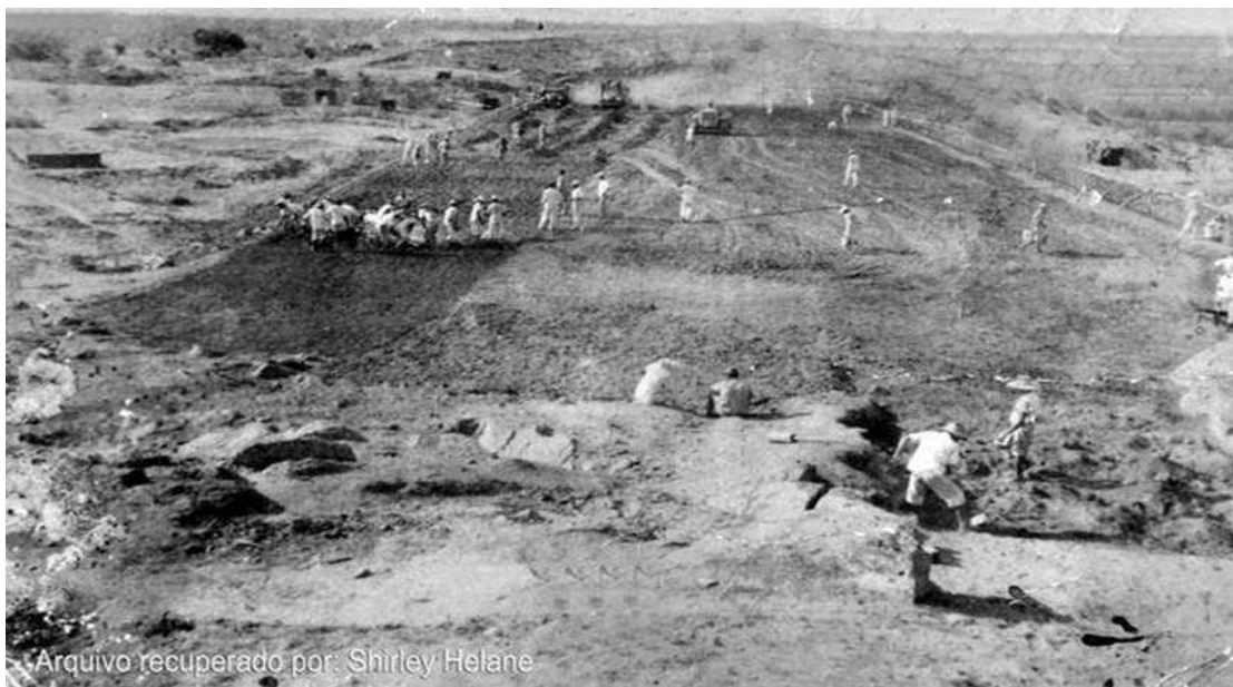
Figura 04- Frente de trabalho na construção do açude Estevam Marinho.
