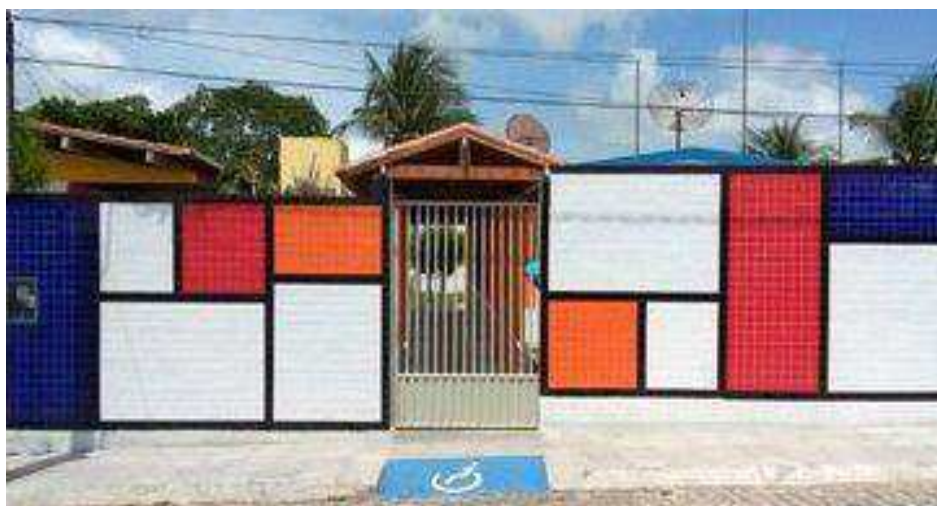
Imagem 03: Fachada da escola
