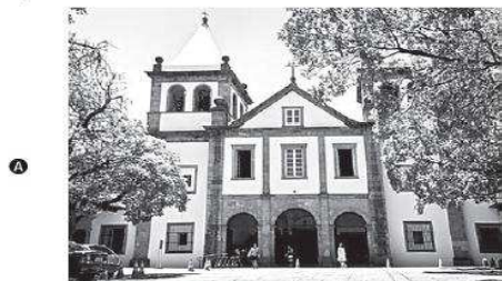
Mosteiro de São Bento (RJ)
