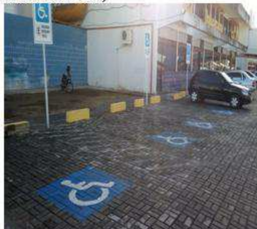
Figura 6 – Estrutura externa (vaga no estacionamento)
