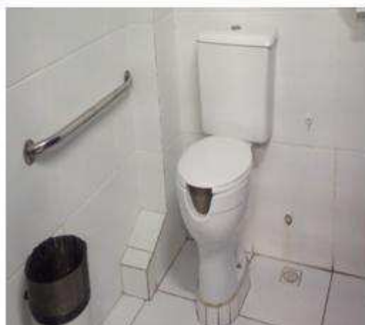
Figura 10 – Banheiro (espaço interno)
