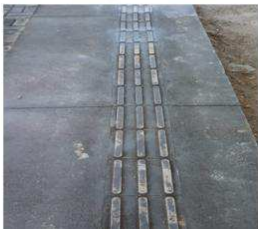
Figura 7 – Piso tátil (área externa)
