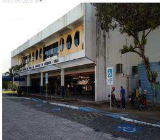
Figura 5 – Estrutura externa (rampas de acesso)
