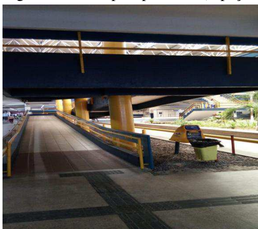
Figura 11 – Rampa e piso tátil (espaço interno)
