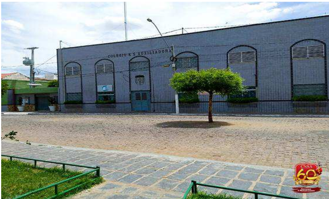
Figura 3 - Entrada do Colégio Nossa Senhora Auxiliadora
