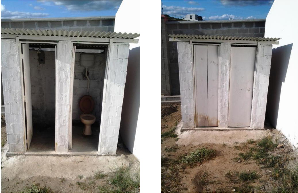
Figura 7 - Sanitário para banho e necessidades fisiológicas.
