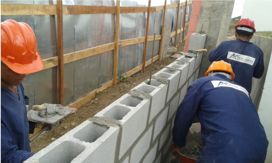
Figura 3 - Operadores em obra.
