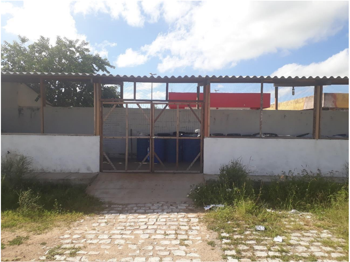
Figura 7 - Depósito de armazenamento externo para lixo infectante
