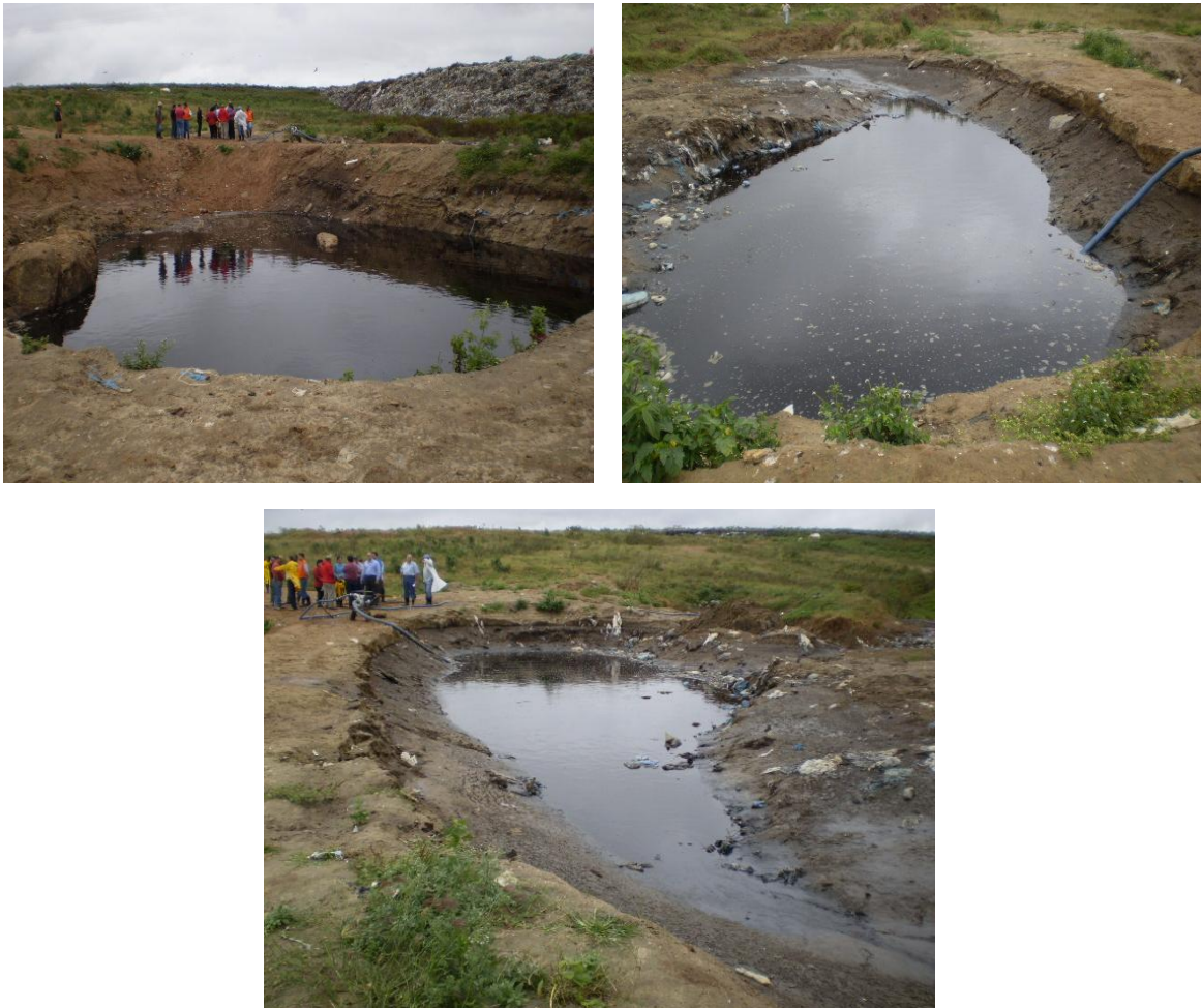
Figura 12: valas de concentração do chorume Fonte: Defesa Civil de Campina Grande (2006)
