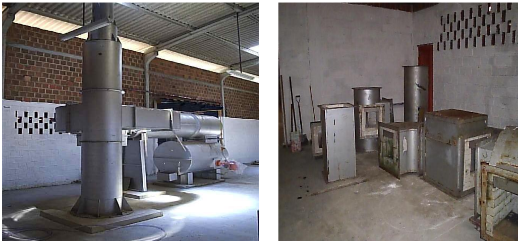
Figura 08: equipamentos utilizados na incineração dos RSS Fonte: Defesa Civil de Campina Grande (2007)
