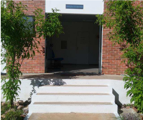
Figura 22 - Escada do Bloco1
