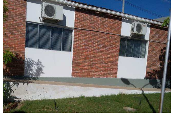
Figura 23 - Rampa do Bloco1
