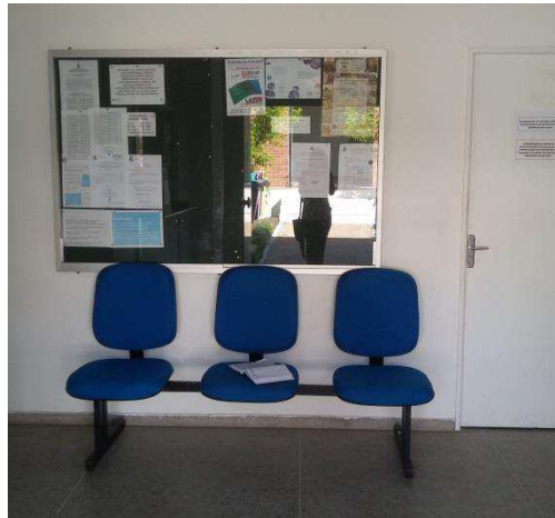
Figura 18 - Banco obstruindo passagem
