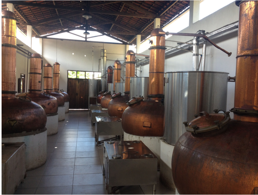
Alambiques (Etapa de destilação)
