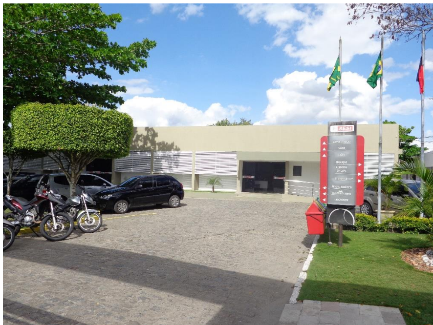
FIGURA 2 - Parte da estrutura do Centro de Atendimento João Rique Ferreira
