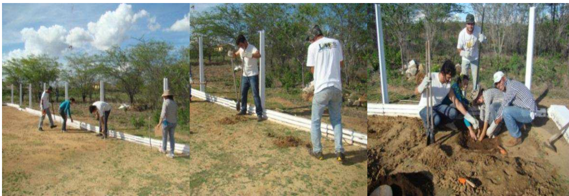
Figura 3 – Marcação e escavação para posterior plantio das mudas
