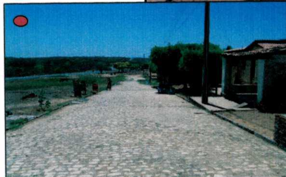
Rua pavimentada às margens da BR-230
