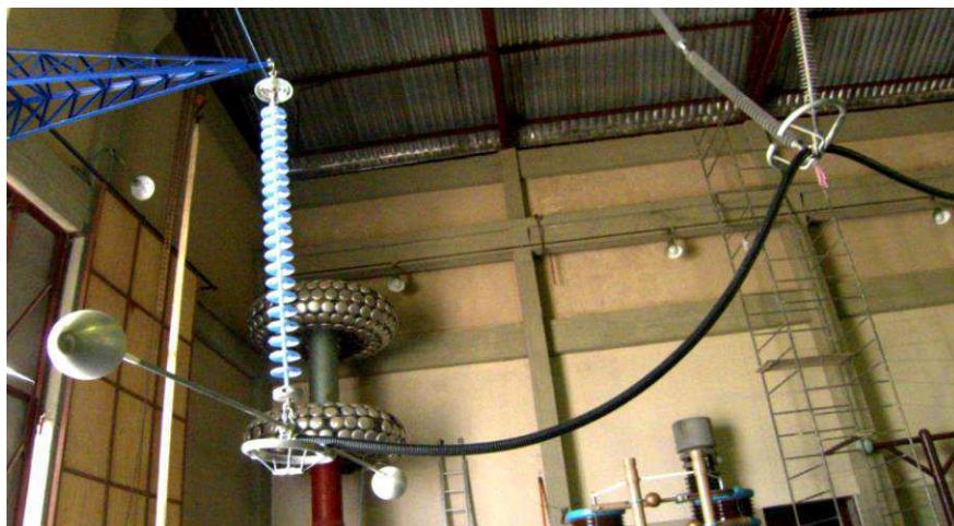
Figura 4.3 - Imagens parciais da montagem com o isolador e o transformador utilizados.
