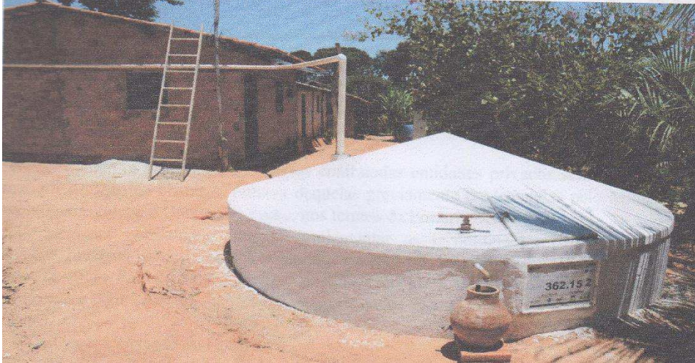
Figura 01: Cisterna finalizada em um sítio da zona rural de Sumé.
