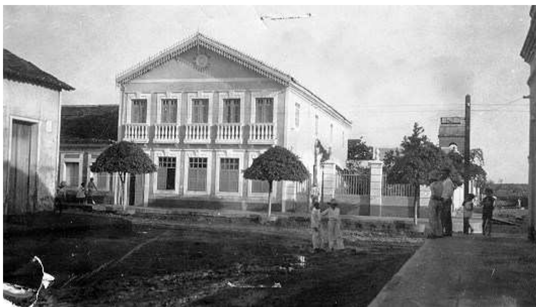
Foto 2.1 - Solar de Joaquim Costa , edificado em 1917 - Primeiro Sobrado de Cajazeiras. Em 1960 foi reformado e adaptado por Tota Assis para funcionar o Grande Hotel. Atualmente o prédio passou por nova reforma e foi desmembrado em lotes menores. Fonte: COSTA, Antônio Assis. A(s) CAJAZEIRAS QUE EU VI E ONDE VIVI. João Pessoa, 1986.
