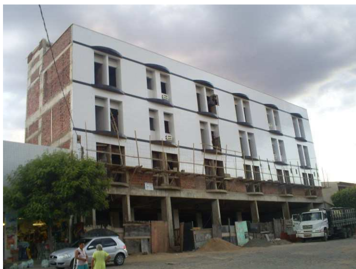
Foto 2.26 - Edifício que funcionara no térreo o Supermercado Palmeiras. - Foto: Leidjânia Dantas de Abreu out 2009
