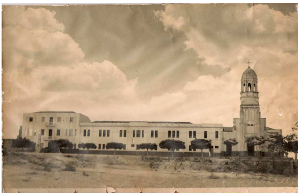
Foto 2.5 - Colégio Diocesano Padre Rolim. - Na década de 90 do século passado foi construída uma quadra esportiva que cobre parte de sua fachada. Fonte: Acervo de Leopoldo de Souza Ferreira. (Borracha).
