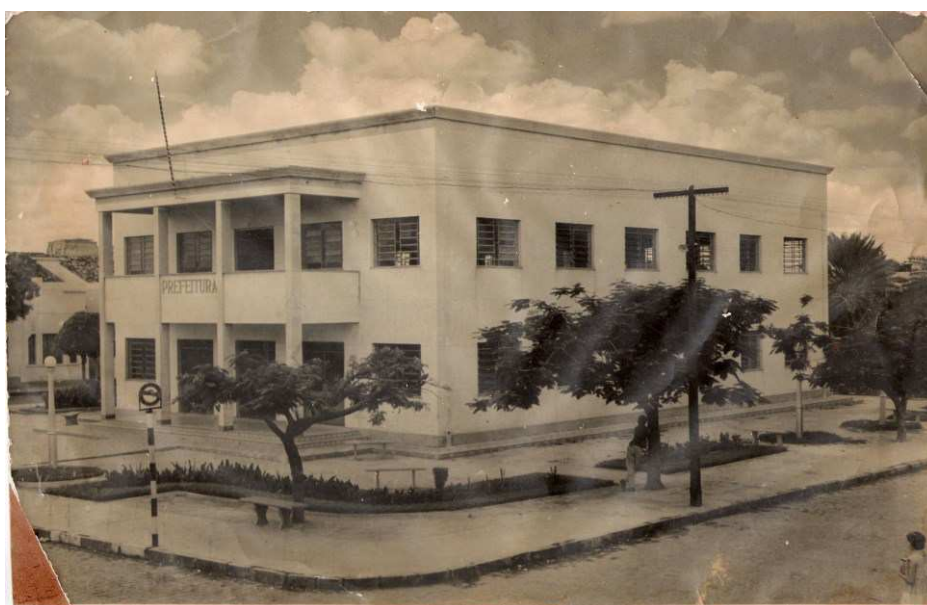
Foto 2.15 - Edifício da Prefeitura Municipal de Cajazeiras. - Situado na rua Juvêncio Carneiro, Centro da cidade. Fonte: Acervo de Leopoldo de Souza Ferreira. (Borracha).
