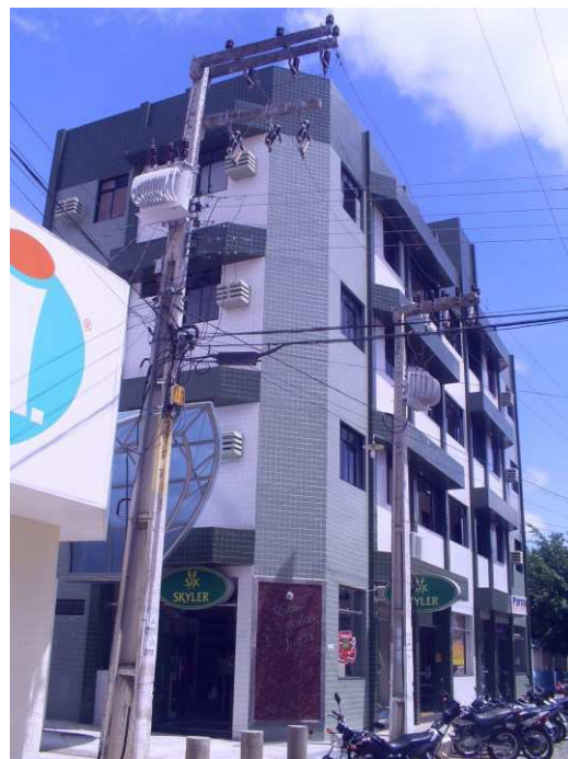
Foto 2.28 - Edifício Situado Calçada Tenente Sabino. - Foto: Leidjânia Dantas de Abreu, out., 2009
