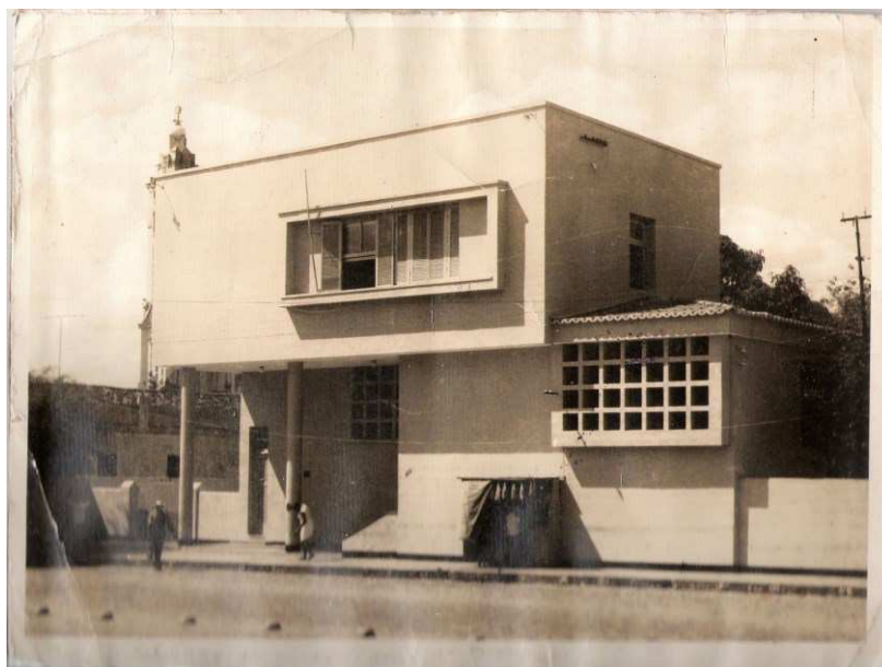
Foto 2.13 - Sede dos Correios e Telégrafos -. O prédio passou por uma reforma e atualmente apresenta-se apenas com o pavimento térreo e outra fachada. Situado à rua Juvêncio Carneiro. Fonte: Acervo de Leopoldo de Souza Ferreira. (Borracha).
