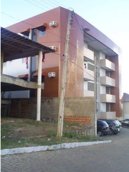
Foto 237 - Edifício Pedro Abrantes. Fachada. - Foto: Leidjânia Dantas de Abreu, out., 2009.
