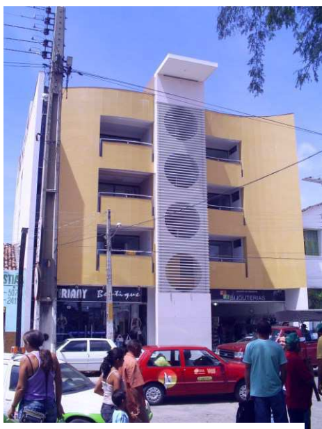
Foto 2.25 - Edifício que funciona a loja Martiliane.- Foto: Leidjânia Dantas de Abreu, out., 2009.
