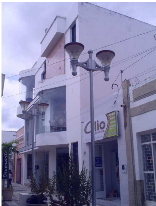
Foto 2.35 - Edifício da Decorart. - Situado no Calçadão T. Sabino. Foto: Leidjânia Dantas de Abreu, out., 2009.
