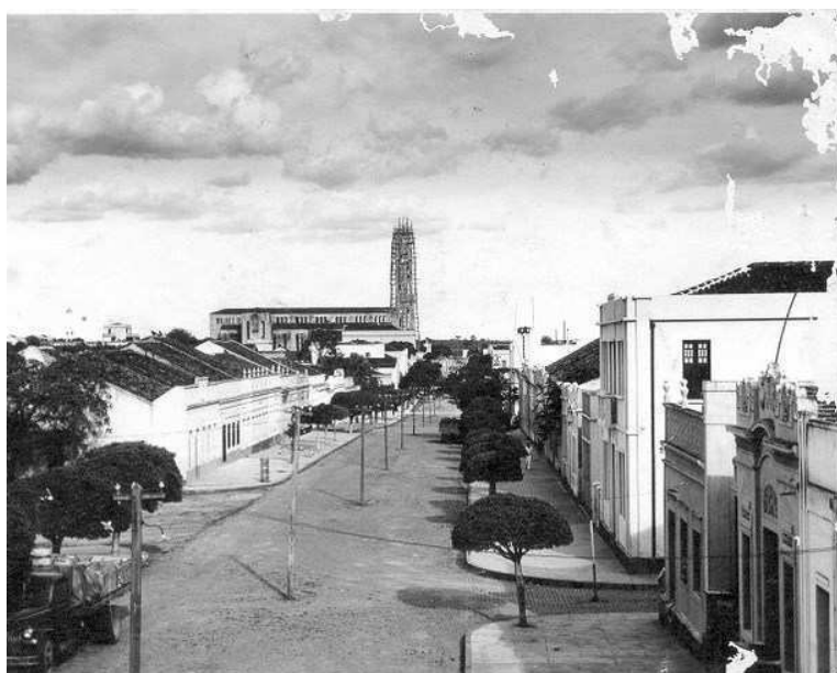
Foto 2.3 - Vista panorâmica da construção da Catedral - (meados do século XX). Visão do início da rua Padre Rolim no cruzamento da padre José Tomás e Oiticicas. Fonte: Acervo de Leopoldo de Souza Ferreira.
