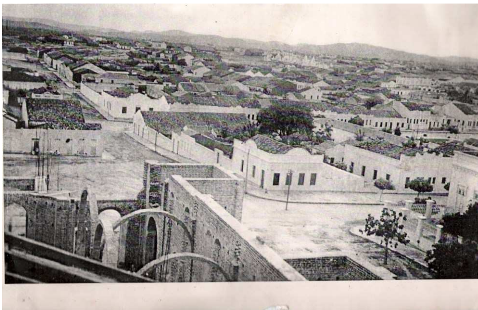
Foto 2. - Início da construção da Catedral Nossa Senhora da Piedade - (início do século XX), a cidade é vista de cima, imagem de construções horizontais. Observamos que a esquerda da foto é visto o início da construção da Catedral apresentando alguns arcos. Está situada a rua é a Padre Rolim no centro da cidade. Fonte: Acervo de Leopoldo de Souza Ferreira. (Borracha).
