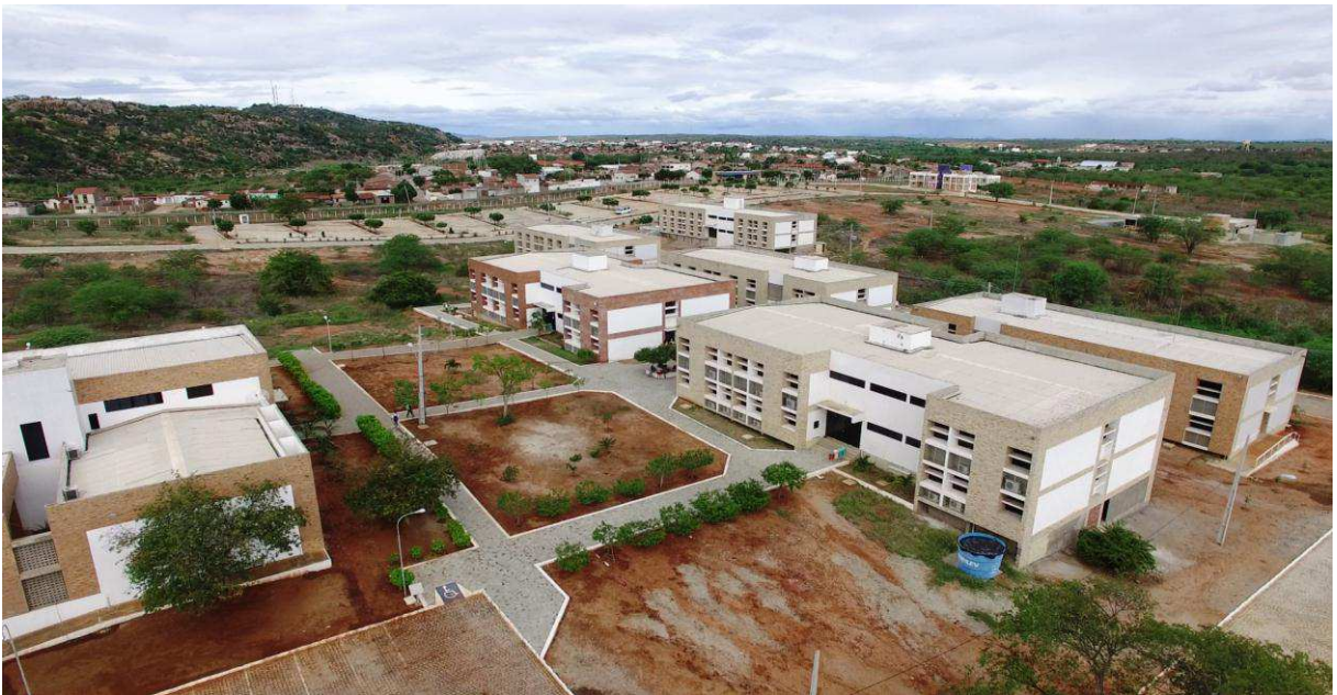
Imagem 2: Visão Geral da Biblioteca e Blocos das Centrais de Aula
