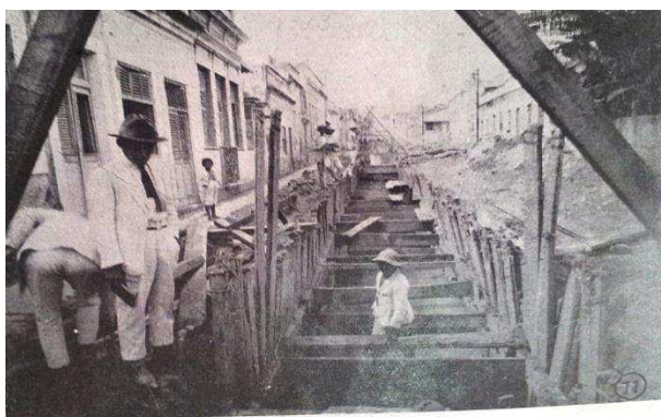
11 — Construção da galeria pluvial na rua Barão da Passagem. A photographia mostra o escoramento de madeira empregado em virtude da natureza do terreno.
