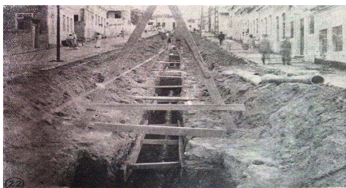
22 — Trecho em construção de collectores dos esgotos
