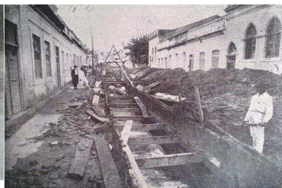
12 — A galeria pluvial, vendo-se a cobertura com as lajes de cimento armado.
