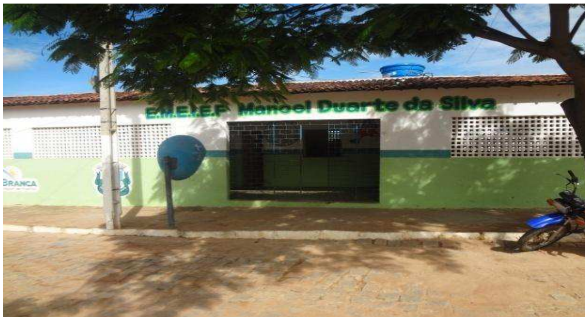
Figura 1 - Escola municipal de ensino infantil municipal Manuel Duarte da Silva fica localizada no distrito do Sucuru - Paraíba Fonte: Acervo da autora.
