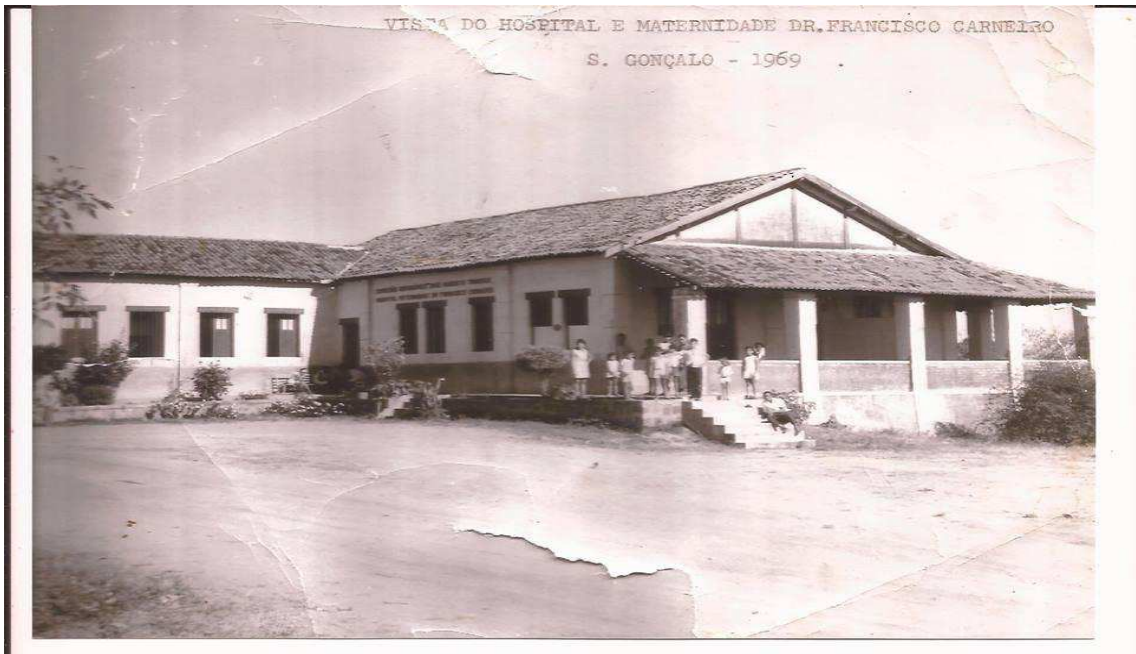
(Imagem 36: Hospital e Maternidade Dr. Francisco Carneiro – São Gonçalo - Fonte: Sr. José Messias Filho).
