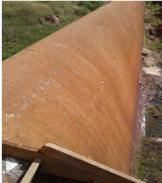
(Imagem 13: Sangradouro do Açude Público de São Gonçalo - Arquivo pessoal: 22/05/2017)
