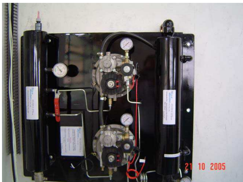
Figura 3.24 – Sistema de redução de pressão.
