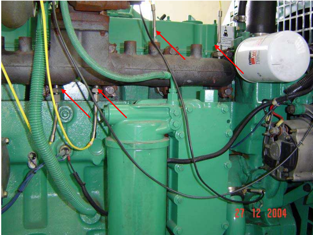
Figura 3.8 – Termopares instalados no coletor de escapamento.
