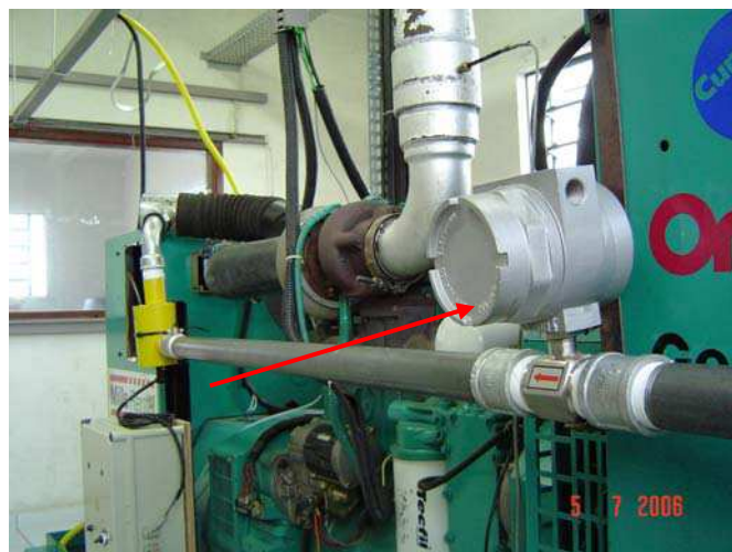
Figura 3.21 - Medidor de vazão de gás natural.
