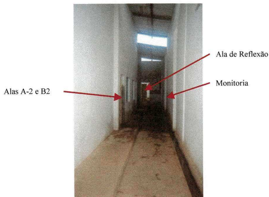
Foto14- Corredor de acesso às Alas: A2, B2, Ala de Reflexão e quarto dos monitores.
