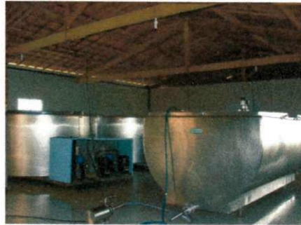
Foto 6: Tanques de resfriamento para leite de cabra (esquerda) e leite de vaca (à direita)
