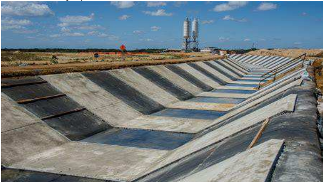
Figura 5: Obra da transposição do Rio São Francisco.
