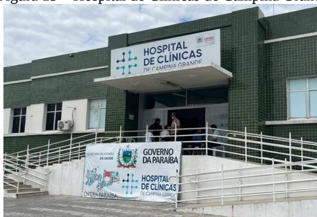
Figura 15 – Hospital de Clínicas de Campina Grande
