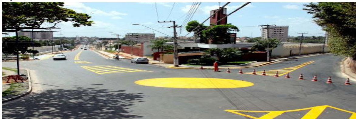
Figura 28 - Avenida Mário Andreazza em São Luís
