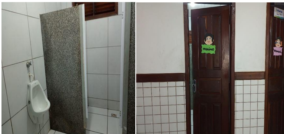
Figura 36 - Banheiros (imagens interna e externa)
