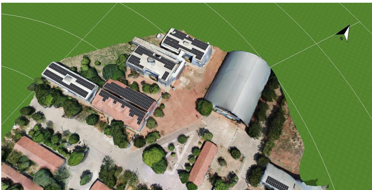
Figura 69: Vista aérea detalhada 04: Módulos solares instalados sobre prédios da UFCG.
