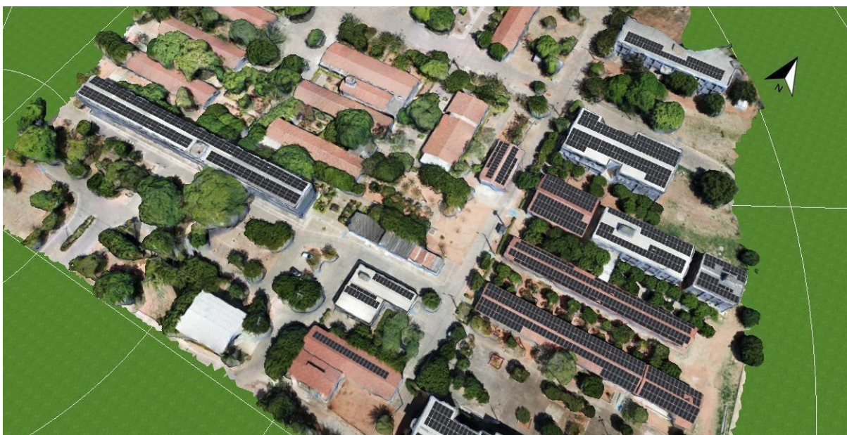
Figura 67: Vista aérea detalhada 02: Módulos solares instalados sobre prédios da UFCG.
