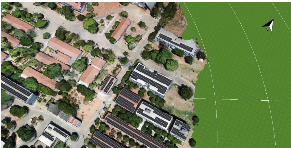
Figura 68: Vista aérea detalhada 03: Módulos solares instalados sobre prédios da UFCG.
