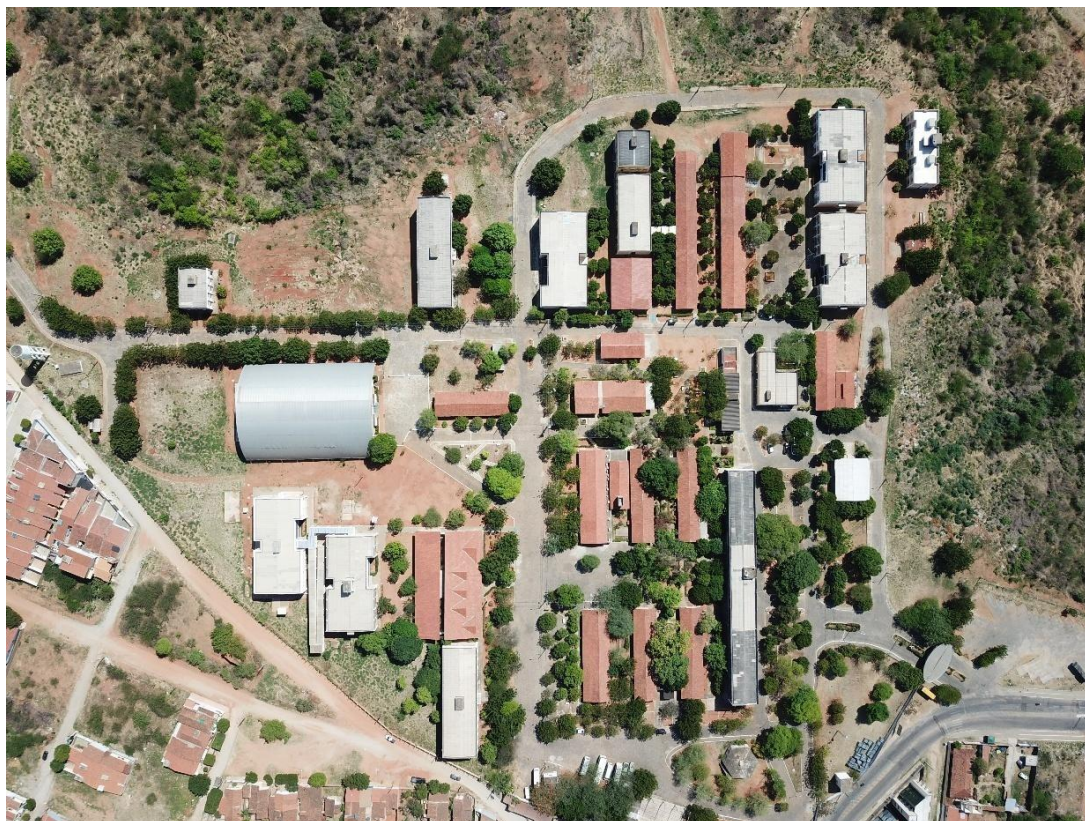
Figura 52: Vista aérea das áreas disponíveis para instalação dos painéis fotovoltaicos, CFP.
