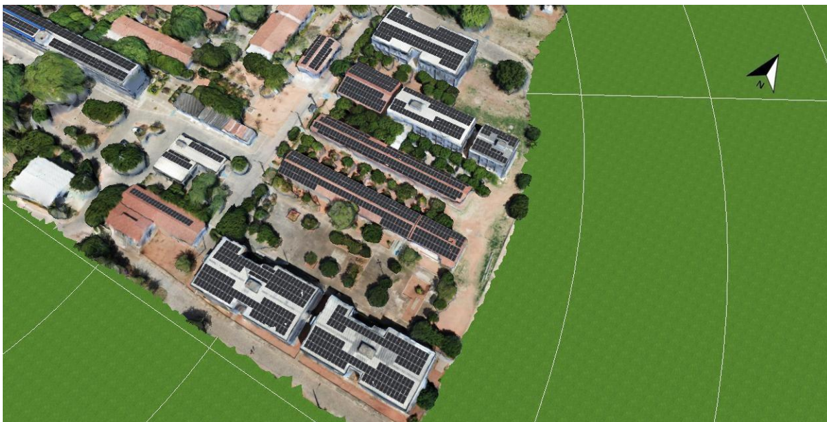
Figura 66: Vista aérea detalhada 01: Módulos solares instalados sobre prédios da UFCG.
