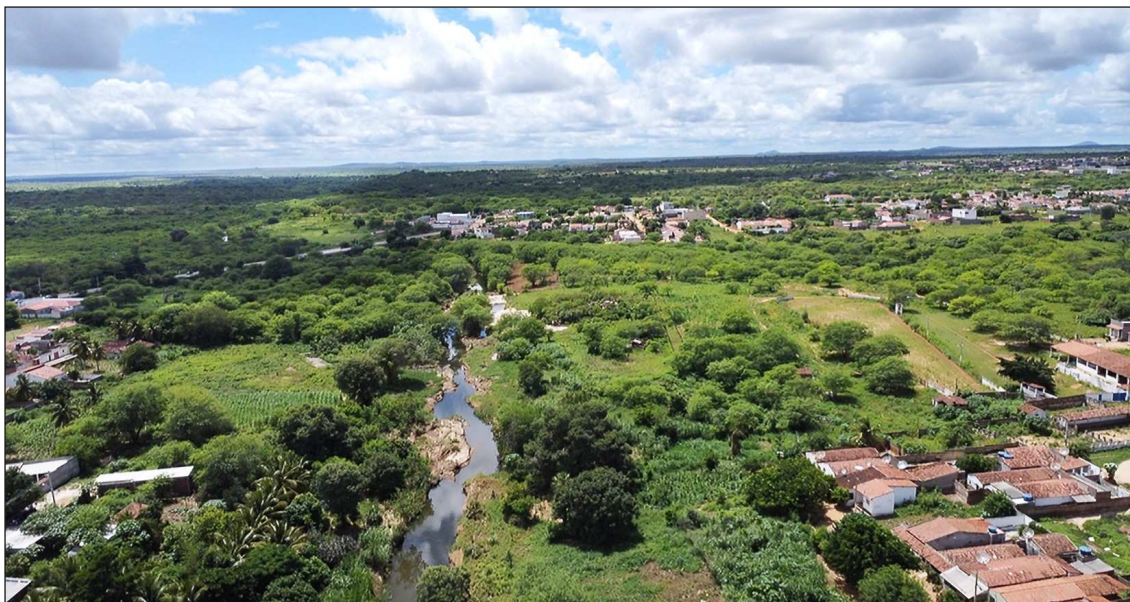
Figura 6.15 Rio Poção. Fonte: Foto dos autores.
