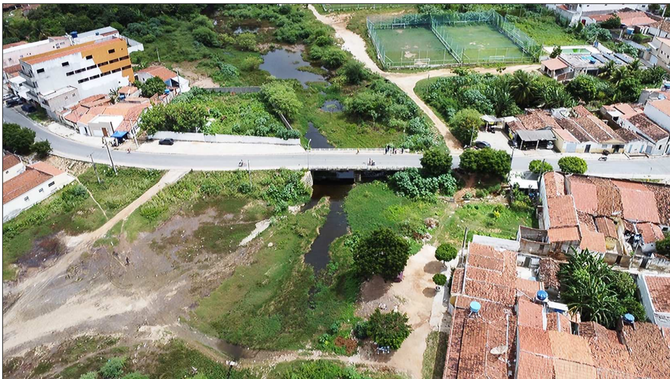
Figura 6.11 Ponte sobre o Riacho da Serra. Fonte: Foto dos autores.
