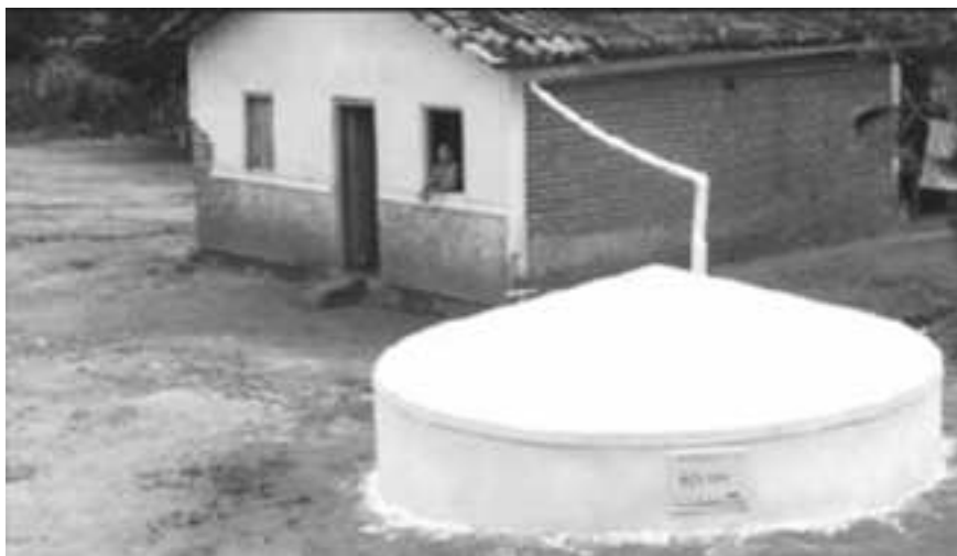
Figura 4. Cisterna de placa – construída pela metodologia da ASA
