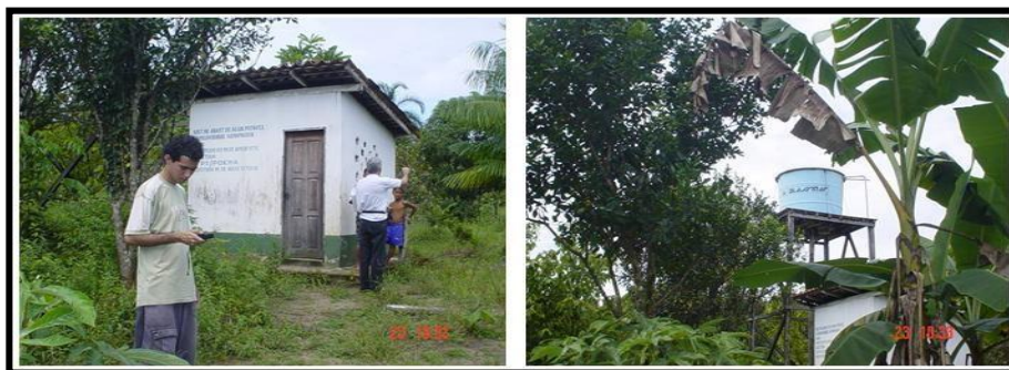
Fotografia 13 – Microssistema de abastecimento de água na comunidade.
