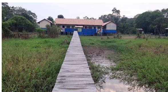
Imagem 24 – Chegada e acesso à escola pela ponte, em virtude das cheias dos rios.
