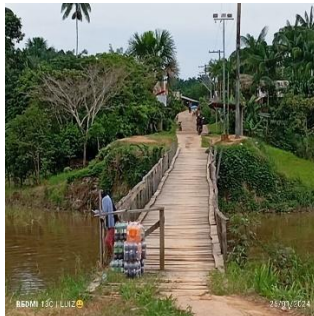
Foto 6 – Ponte de Filadélfia
