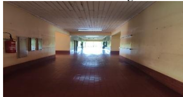
Fonte 16 – Corredor Antigo
