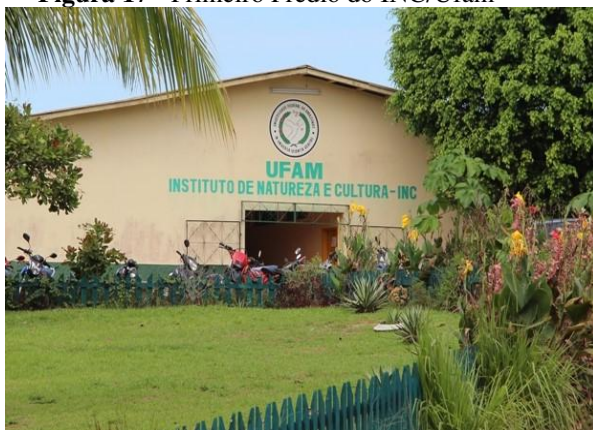
Figura 17 - Primeiro Prédio do INC/Ufam
