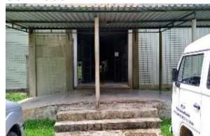
Fotos 17 e 18– Entrada e escada do Bloco 1
