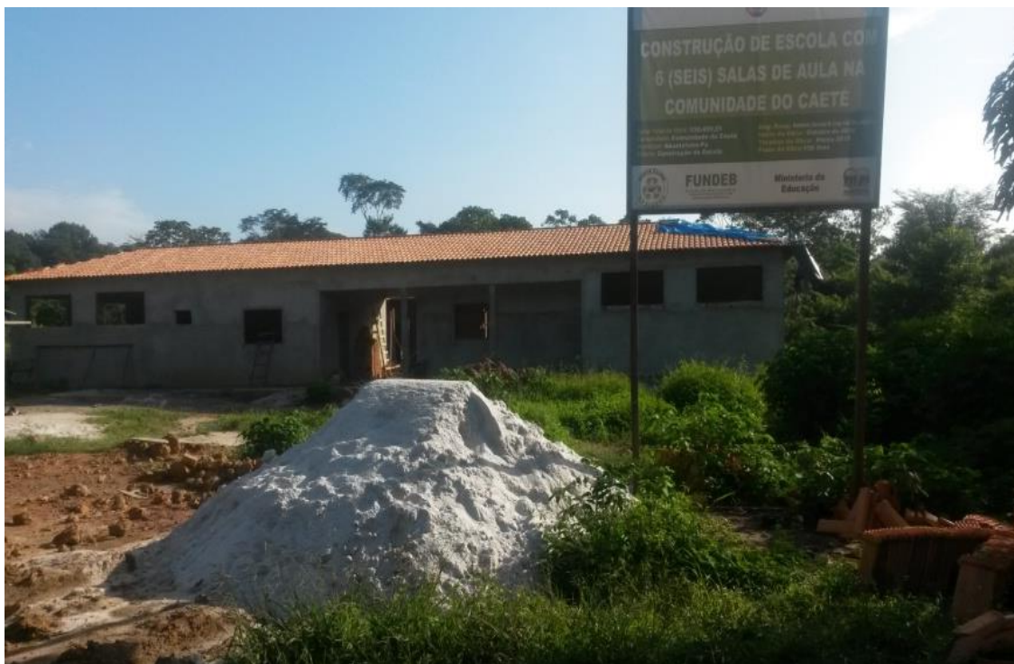
Figura 5 – Fotografia nova escola em fase construção.
