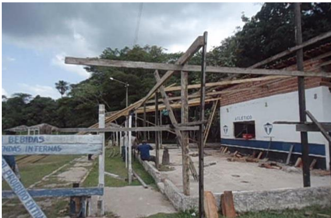
Figura 2 – Fotografia da estrutura em madeira onde foi construída a padaria local.
