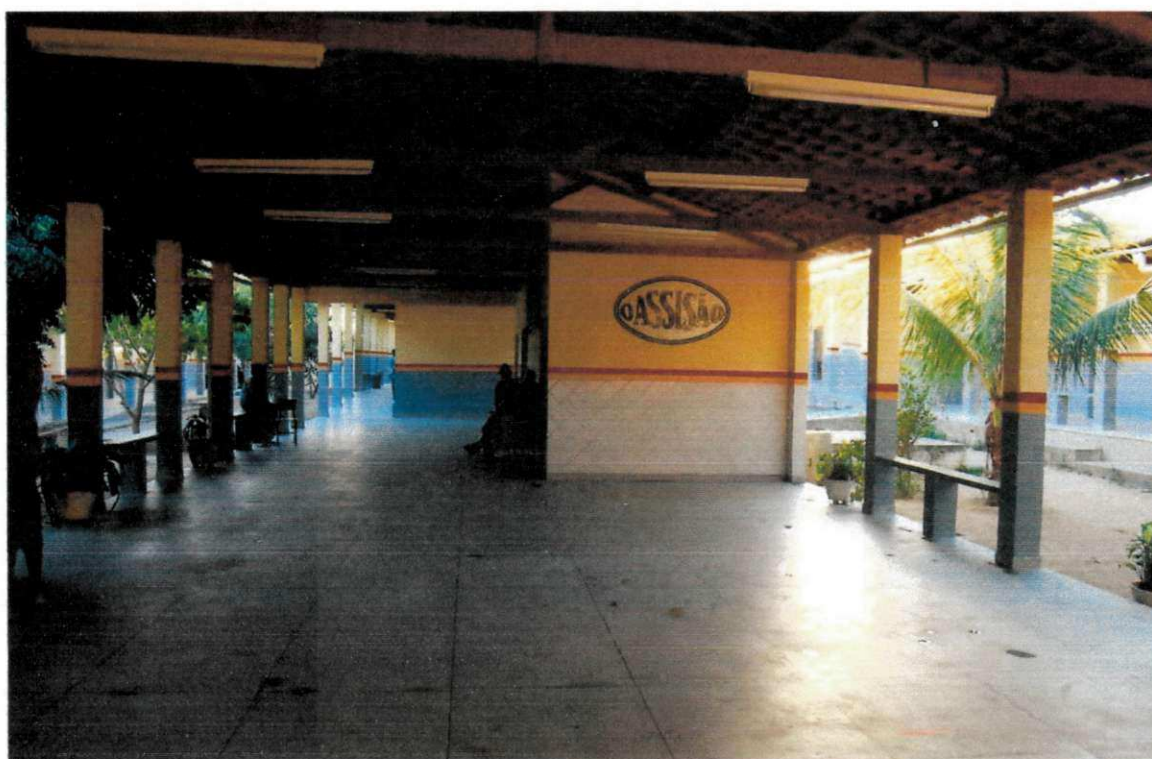
FIGURA 6 – PÁTIO COBERTO DA ESCOLA “O ASSISÃO” (IN LOCO)
