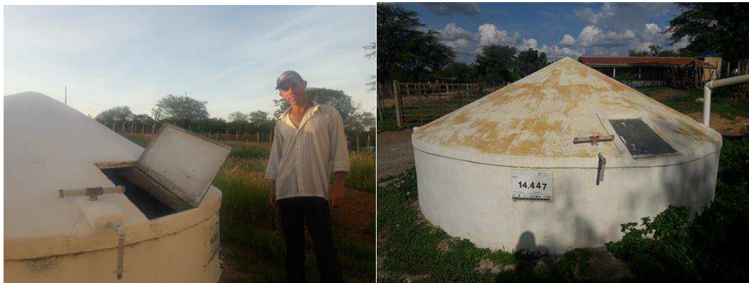
Figura 02 - Cisternas instaladas nas propriedades na comunidade Tingui – Monteiro PB
