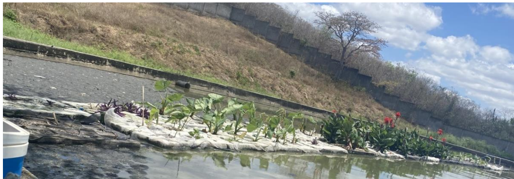
Figura 24 - Sistema Novo de jardins flutuantes implantado na lagoa anaeróbia.
