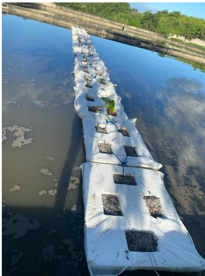
Figura 17- Instalação dos módulos do SJF em fileiras na lagoa anaeróbia
