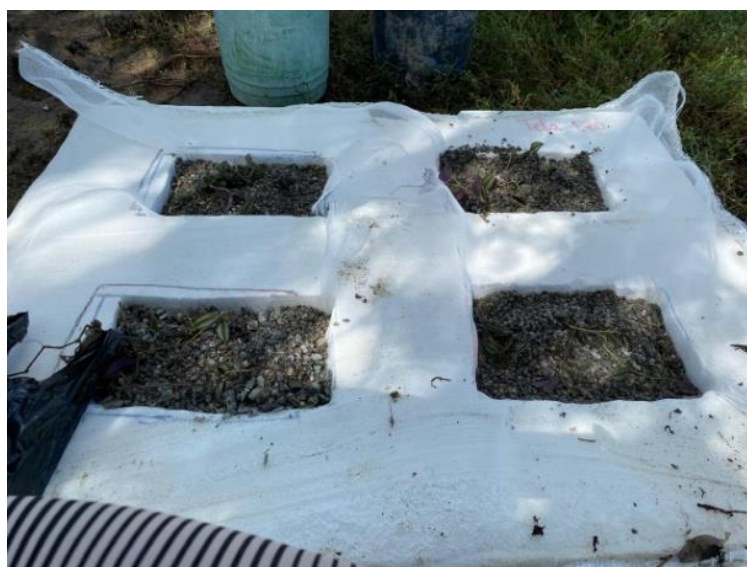
Figura 15- Substrato inorgânico inserido nos berços da estrutura de EPS
