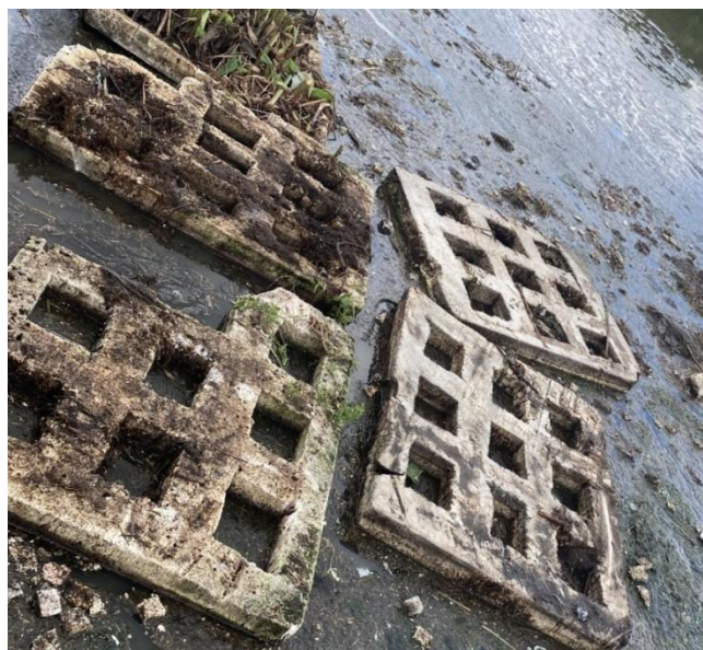
Figura 22 - Módulos instalados por Rocha (2022) após a retirada da vegetação em 12/05/2023.
