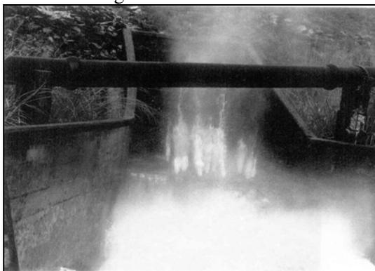
Figura 1 – Explosões devido a emulsionamento de ar na tulipa
